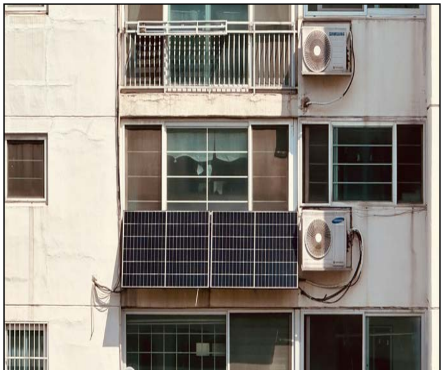
영광군 미니태양광 보급지원사업 설치 모습
