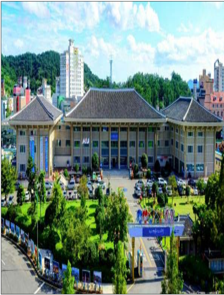
여수시청 전경 사진
