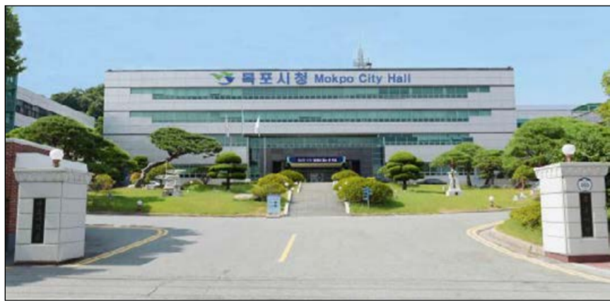
목포시청 전경 사진
