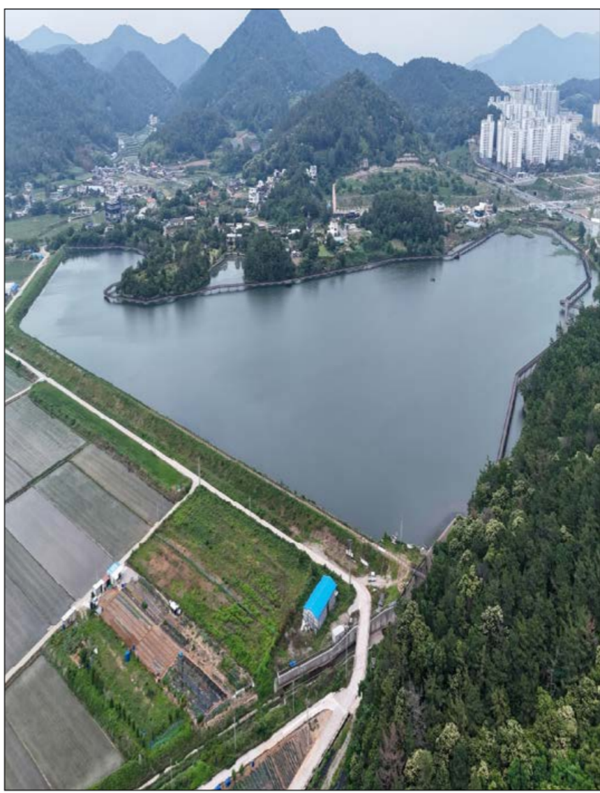
관기저수지 생태공원 조성 현장 전경 사진
