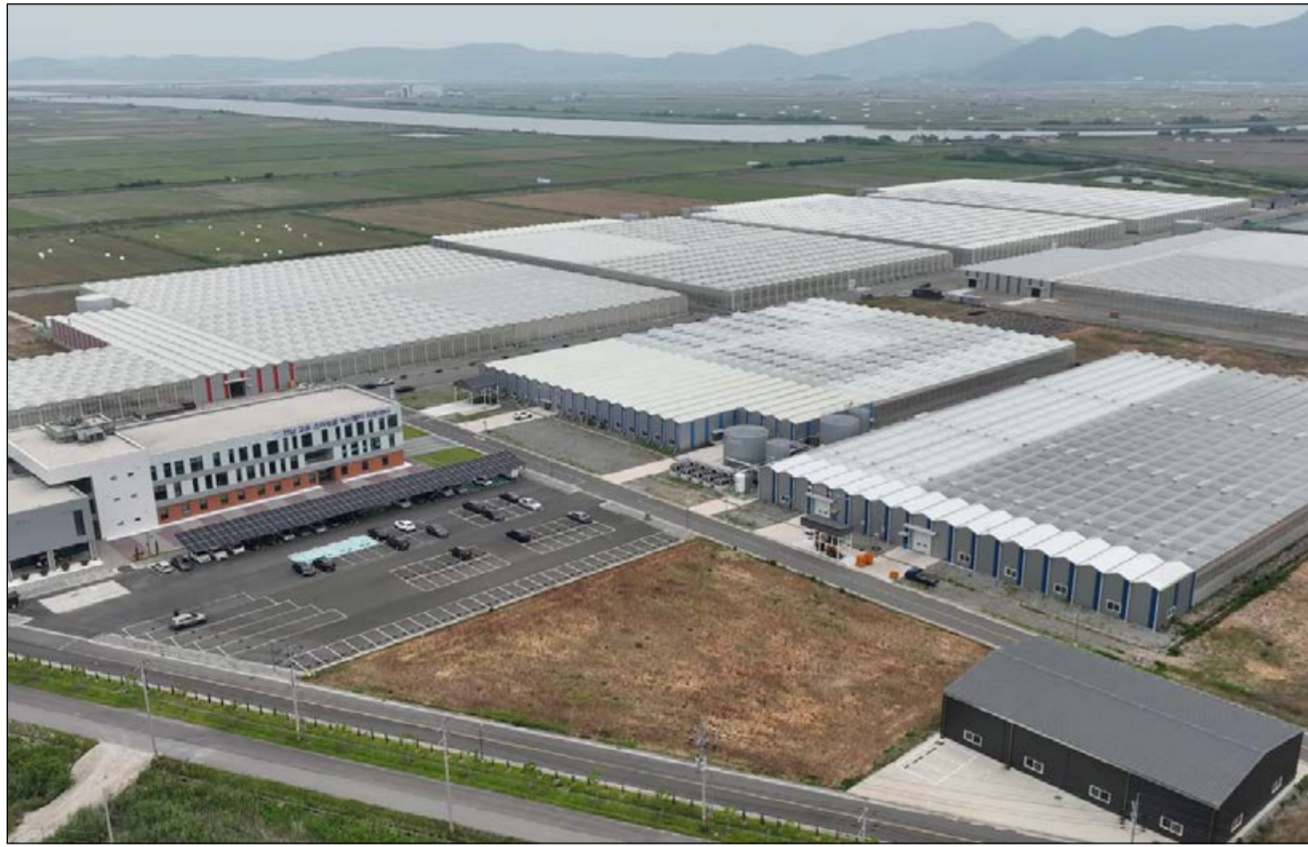
고흥스마트팜혁신밸리 전경 사진
